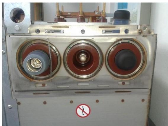
De G à D : extension Jdb monté, extension à monter, bouchon de terminaison.
